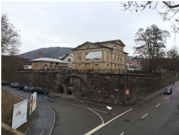
Blick von Westen / Bahngleise
