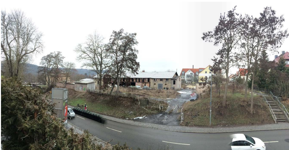
Blick von Süden, Zufahrt Rohrer Straße
