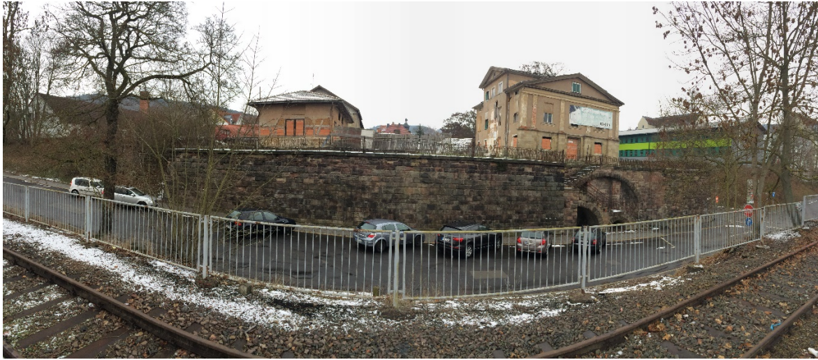
Blick von Westen / Bahngleise
