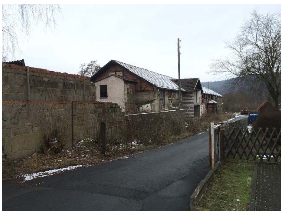
Blick von Osten / Zufahrt Neunkirchener Straße
