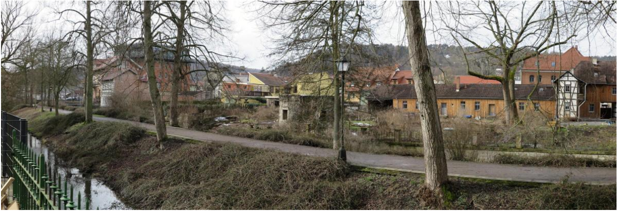
Abbildung 10 Ansicht des Plangebiets über die Bleichgräben hinweg von Osten. In der Mitte Reste der Stadtbefestigung und im Bild rechts davon ebenfalls denkmalgeschützte Fachwerkgebäude
