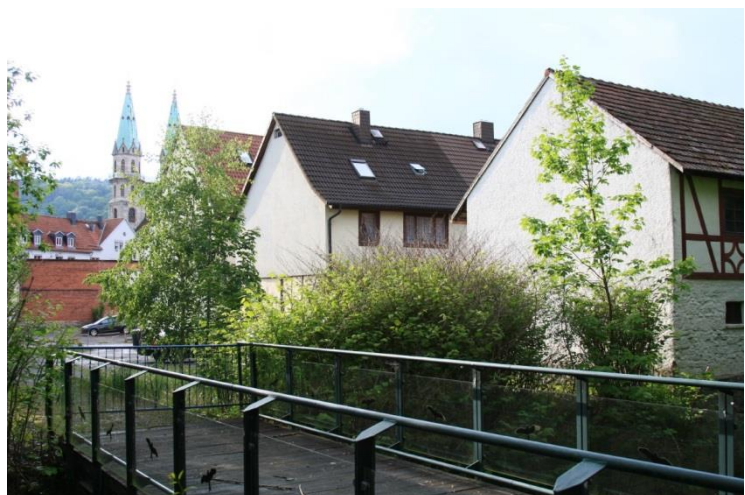
Abbildung 9 Brücke über den Bleichgraben, ehemals Verbindung zwischen Parkhaus und Freitagsgasse. Die Fußgängerverbindung wird zukünftig nicht mehr benötigt. Im Hintergrund die Türme der Stadtkirche.
