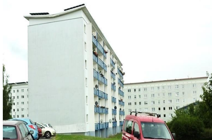
Abbildung 4-10 Großmehrfamilienhäuser, industrieller Wohnungsbau ab ca. 1970 im Versorgungsnetz „HKW Nord“
