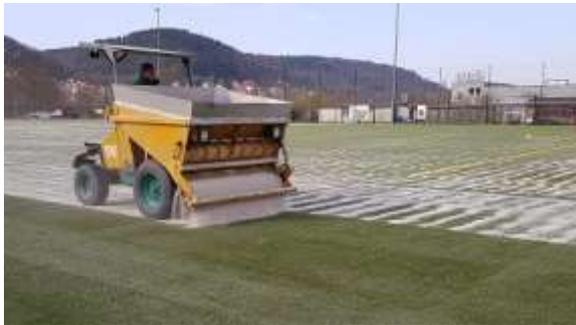
Um die erhöhte Belastung des Kunstrasens auszugleichen, nahm eine Fachfirma die Grundreinigung vor und verfüllte 50 Tonnen Quarzsand auf dem Platz. Auf eine Verfüllung mit neuem Granulat wurde aufgrund der aktuell noch offenen Diskussion zum Thema „Mikroplastik“ und der hohen Investitionssumme verzichtet. Die Bemühungen, den Platz auf Vordermann zu bringen, wurden jedoch Anfang November durch eine auf dem Platz gezündete Konfettikanone torpediert.
