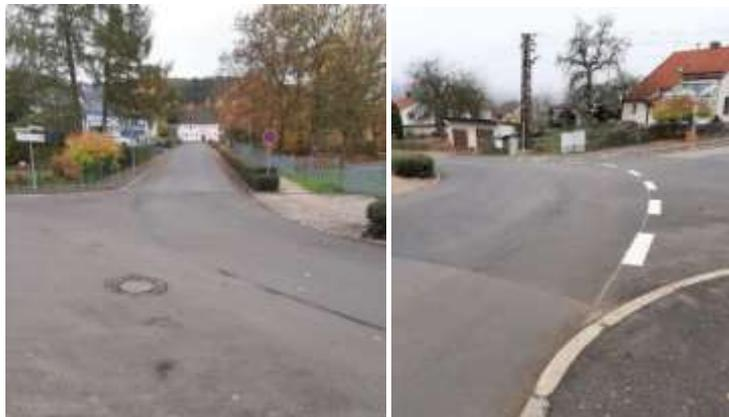
Auch in der sog. **Wasserwerkskurve in der Werrastraße bis zum Kreisverkehr Untermaßfeld** war die Asphaltdeckschicht verschlissen. Sie wurde auf einer Fläche von rund 7.000 m<sup>2</sup> abgefräst und durch eine neue Deckschicht ersetzt. Anschließend wurden die Bankette auf der gesamten Strecke neu hergestellt und die Fahrbahnmarkierung als hochwertige Heißplastik ausgeführt. Die Maßnahme wurde ebenfalls im Juli 2020 durchgeführt und kostete 135.000 Euro.
