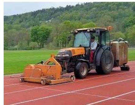
Im nächsten Schritt wurde das unterirdische Rohrsystem mit einer Hochdruckspülung gereinigt. Damit sollten alle verbliebenen Verunreinigungen entfernt werden, damit bei einem Hochwasser das Wasser schnell abfließen kann. Diese Spülmaßnahmen nahmen eine weitere Woche in Anspruch. Im abschließenden Arbeitsschritt wurde die Laufbahn mit einem Hochdruckverfahren gereinigt. Während der Intensivreinigung traten mehrere bis dahin verdeckte Beschädigungen und
