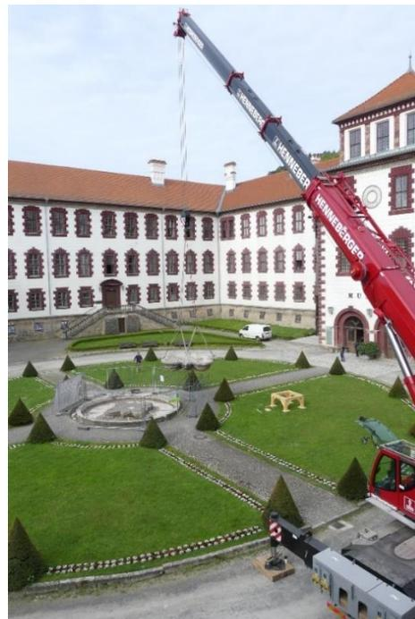
*Die demontierte Brunnenschale und die mittlere Marmorschale wurden mit einem Kran demontiert. Links unten im Bild das fertiggestellte Bassin samt Sockel.*
