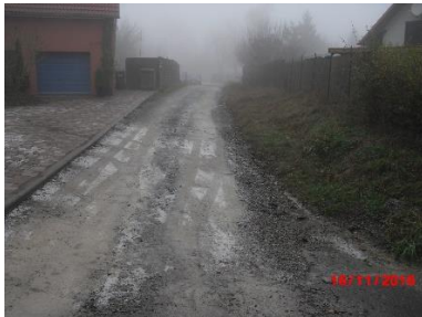
Der Zustand vorher
