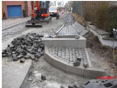
Entwässerungsgraben und Gebirgeinlauf sowie...
