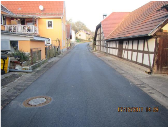
Fertigstellung Mühlstraße OT Sülzfeld
