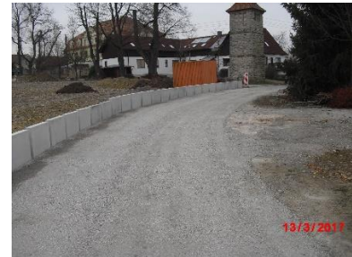
...die Straßendecke werden hergestellt.
