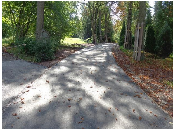
... und nach der Sanierung
