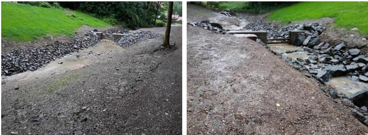
*Der Geschieberückhalt mit Stauwehr am frisch sanierten und stabilisierten Dreißigackerer Bach*
