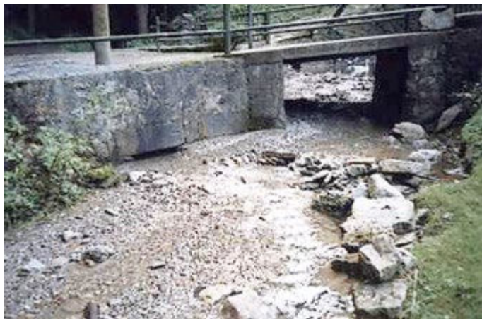
Links der Spörersbrücke erkennt man gerade noch den Ausfluss der Quellstube der Unteren Kreuzbergquelle, von M. Lang als Brunnensammelstube bezeichnet. Die Aufnahme entstand, bevor Familie Raab hier mit den Wiederherstellungsarbeiten begann.
