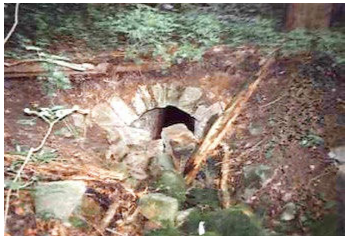
Das Wasser der Oberen Kreuzbergquelle floss durch dieses Gewölbe unter der Straße hindurch in den Dreißigäckerer Bach.
