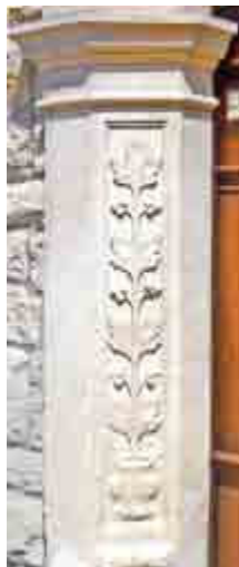
Portal am Steinernen Haus in der Anton-Ulrich-Straße
